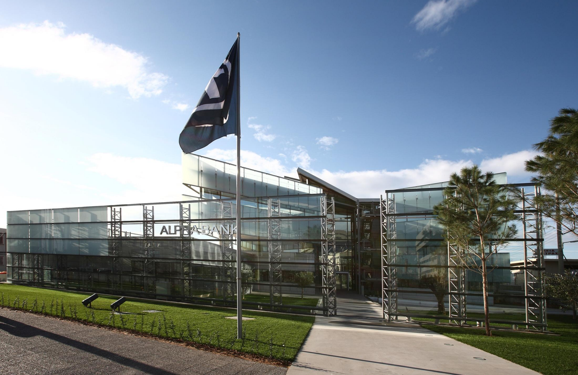
Κτήριο γραφείων και κατάστημα Alpha Bank, Αθήνα (2008)
